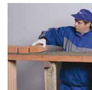
50. Murovanie tlačenej oblasti
