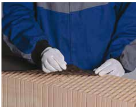
18. Uzavretie konštrukcie steny bitúmenovou izolačnou doskou
