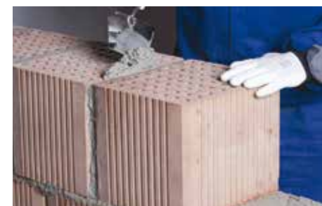
36. Protihluková stena zvislá medzera
