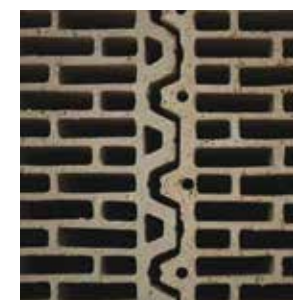
1. Tesne priložené perodrážkové spojenie
