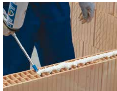
24. Nanesenie univerzálneho lepidla LeierFIX na strednú drážku priečkovky
