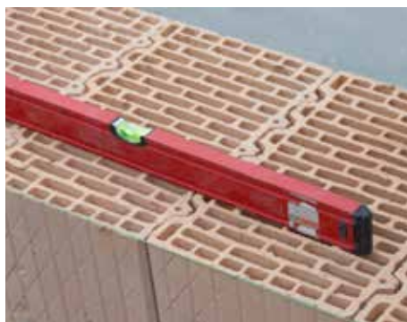
17. Kontrola steny vodováhou
