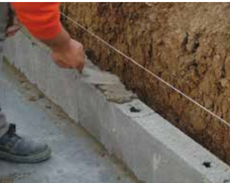
3. Nanesenie maltovej vrstvy
