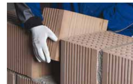
37. Umiestnenie rezaného prvku do protihlukovej steny
