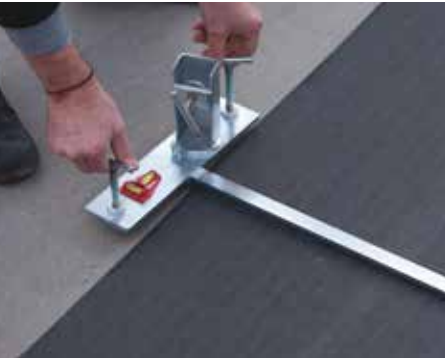
6. Nastavenie úrovne na nivelačnom sete
