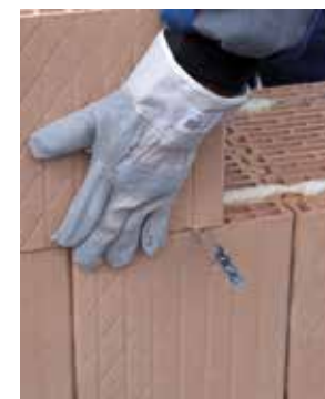
20. Umiestnenie tvárnice pri spojení stenovej spony
