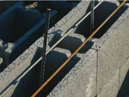
7. Zvislé a vodorovné armovanie pred betónovaním
