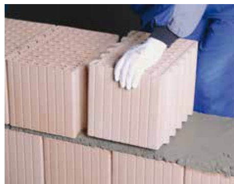
3. Vloženie murovacieho prvku do maltového lôžka
