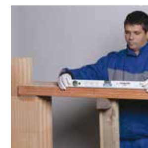
49. Kontrola vodorovnej polohy
