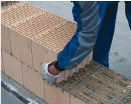
11. Murovanie pri šnúre
