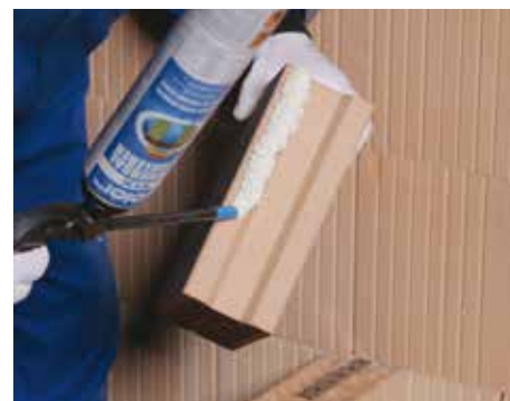
26. Nanesenie lepidla na zvislú plochu tvárnice pri spojoch
