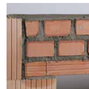
52. Vytvorenie hornej roviny pri stene LeierPLAN
