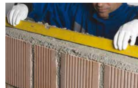
38. Stavba protihlukovej steny: vytvorenie
