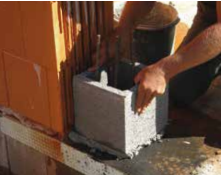
9. Umiestnenie prvej debniacej tvárnice
