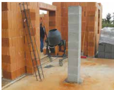
11. Stĺpové debnenie a vystuženie
