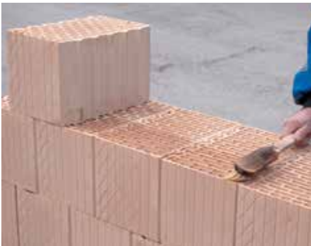
13. Navlhčenie murovacieho prvku LeierPLAN pred lepením
