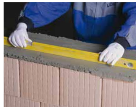
4. Murovacou maltou vytvorená vrstva
