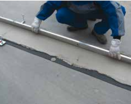
8. Vytvorenie maltového pásu pod prvým radom
