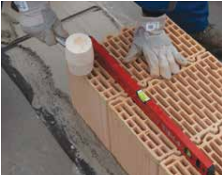
9. Vyloženie prvého radu
