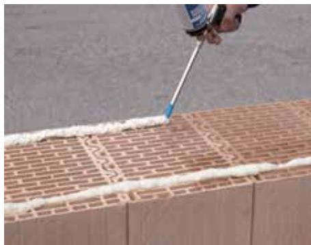
15. Naneste univerzálneho lepidla LeierFIX 5 – 6 cm od okrajov
