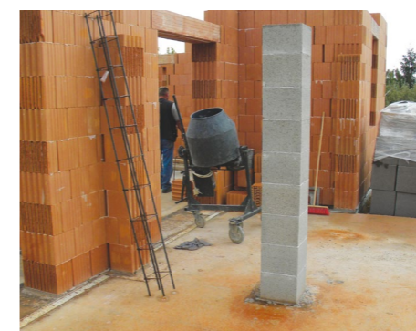
11. Stĺpové debnenie a vystuženie
