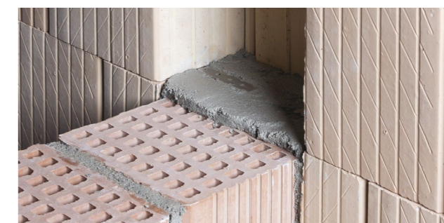
33. Spojenie protihlukovej steny s vonkajšou nosnou stenou vyrobenou z tvárnic LeierPLAN stenovou sponou.
