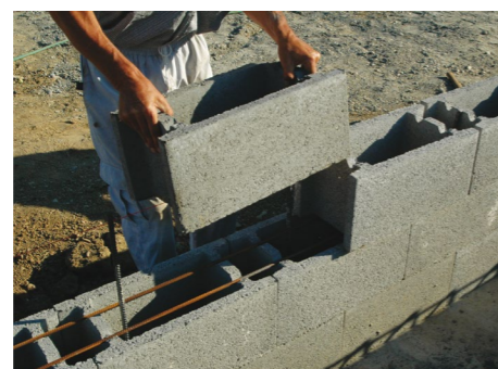
6. Prvky usporiadané do väzieb
