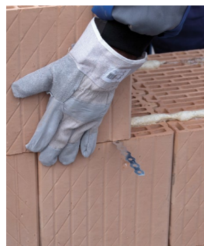
20. Umiestnenie tvárnice pri spojení stenovej spony
