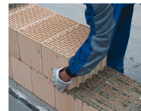
11. Murovanie pri šnúre
