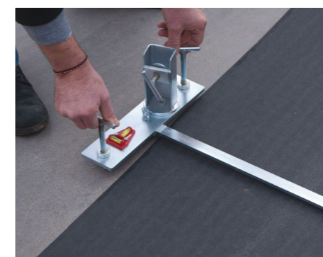
6. Nastavenie úrovne na nivelačnom sete
