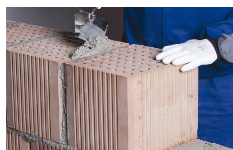
36. Protihluková stena zvislá medzera
