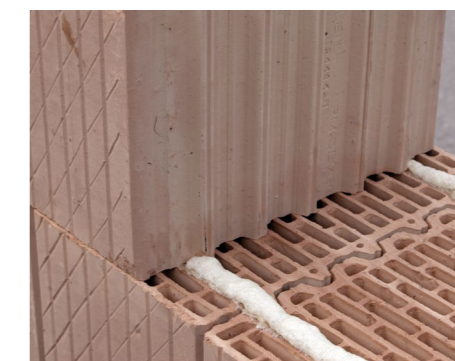
16. Murovací prvok vložený do univerzálného lepidla LeierFIX
