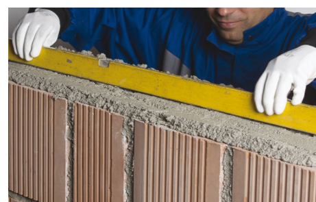
38. Stavba protihlukovej steny: vytvorenie
