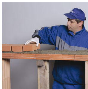
50. Murovanie tlačenej oblasti
