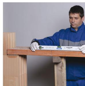
49. Kontrola vodorovnej polohy
