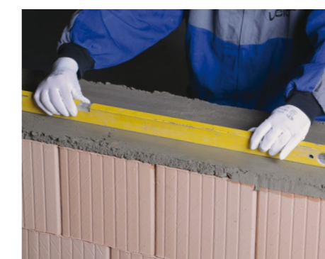
4. Murovacou maltou vytvorená vrstva
