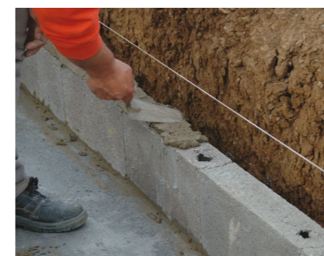
3. Nanesenie maltovej vrstvy
