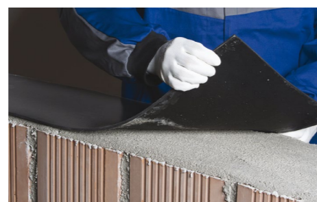
39. Flexibilná podložka na vyrovnávacej vrstve
