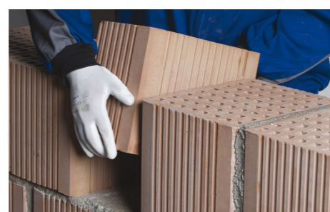
37. Umiestnenie rezaného prvku do protihlukovej steny
