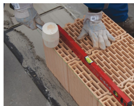
9. Vyloženie prvého radu
