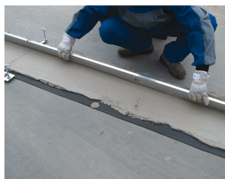
8. Vytvorenie maltového pásu pod prvým radom
