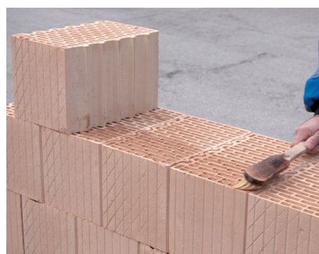
13. Navlhčenie murovacieho prvku LeierPLAN pred lepením
