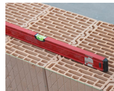
17. Kontrola steny vodováhou
