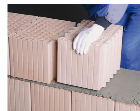
3. Vloženie murovacieho prvku do maltového lôžka
