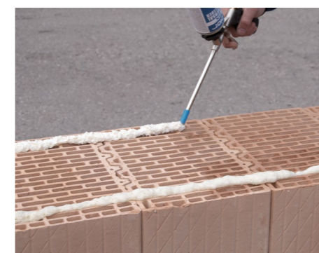
15. Nanesenie univerzálného lepidla LeierFIX 5 – 6 cm od okrajov
