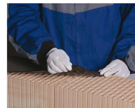
18. Uzavretie konštrukcie steny bitúmenovou izolačnou doskou
