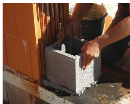
9. Umiestnenie prvej debniacej tvárnic
