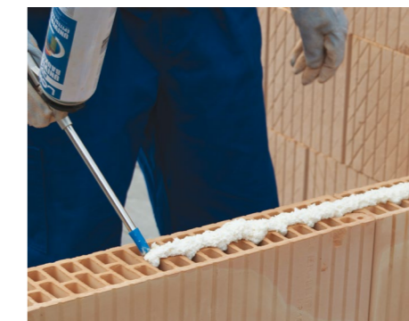
24. Naniesenie univerzálneho lepidla LeierFIX na strednú drážku priečkovky
