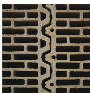
1. Tesne priložené perodrážkové spojenie
