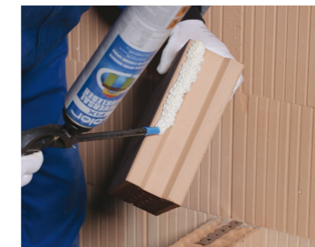
26. Naniesenie lepidla na zvislú plochu tvárnice pri spojoch
