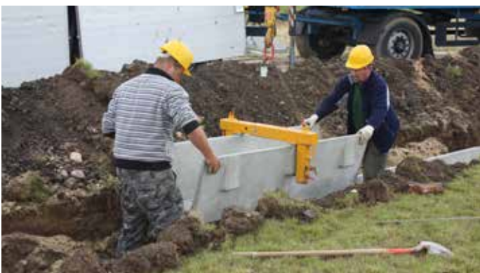
jednoduché osadenie za pomoci špeciálneho dvíhacieho zariadenia
