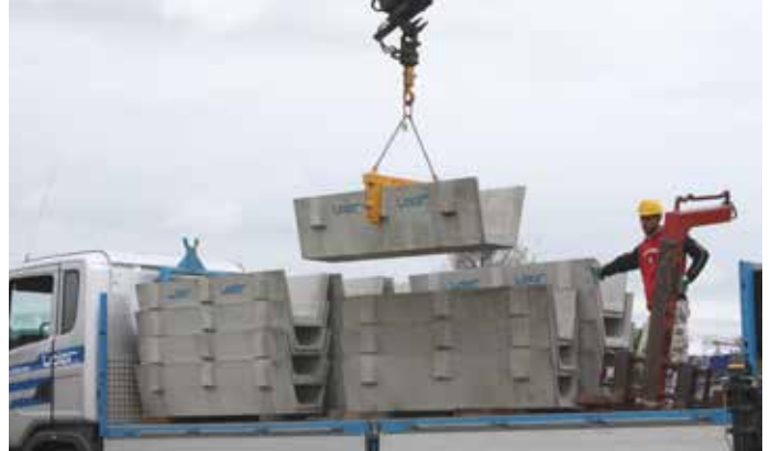
bezpečné zdvíhanie za pomoci špeciálneho dvíhacieho zariadenia
