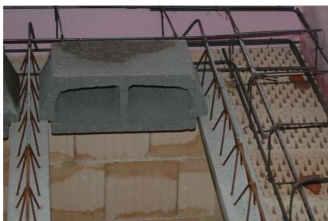
Ukladanie stropných vložiek sa nesmie realizovať v smere nosníkov, lebo by mohlo dôjsť k ich posunutiu, a tým k strate stability celého stropu!
