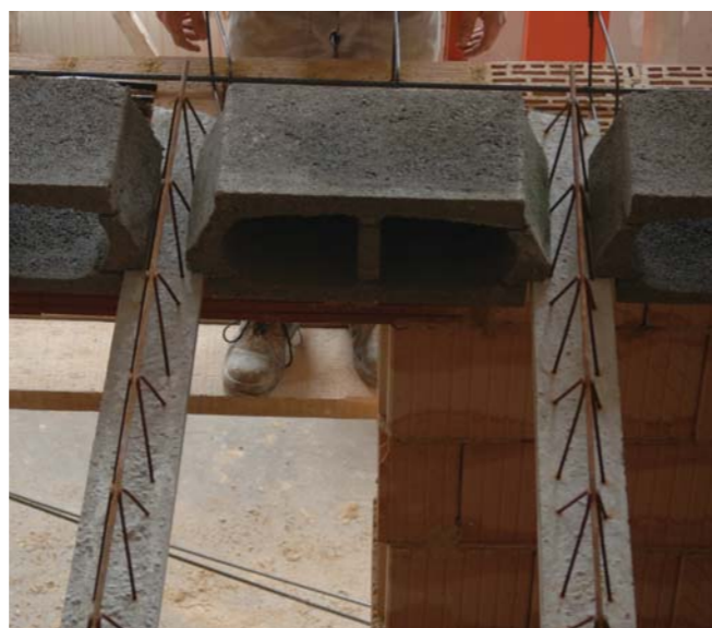
Ukladanie stropných vložiek sa nesmie realizovať v smere nosníkov, lebo by mohlo dôjsť k ich posunutiu, a tým k strate stability celého stropu!
