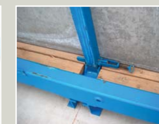
Upevnenie oporného stĺpika
