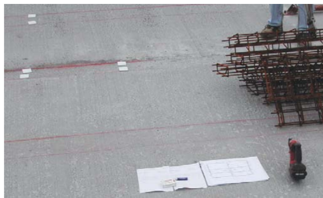
Zabudovanie a montáž sa smie realizovať len na čistý a suchý podklad, ktorý je zbavený prachu.
